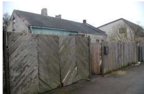
Kopskats uz vērtējamo Objektu no Jaunās ielas puses
